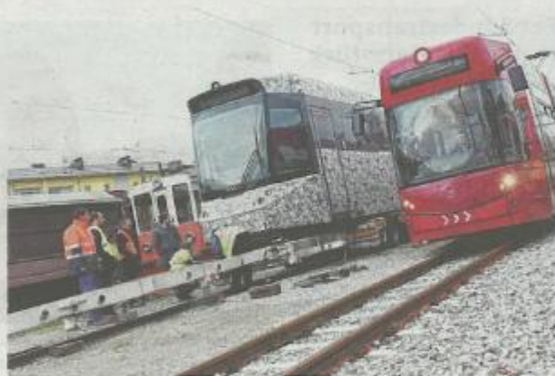
Am 29. August gehen die Bauarbeiten weiter, ab Oktober soll die Traunbrücke neu gebaut werden.
