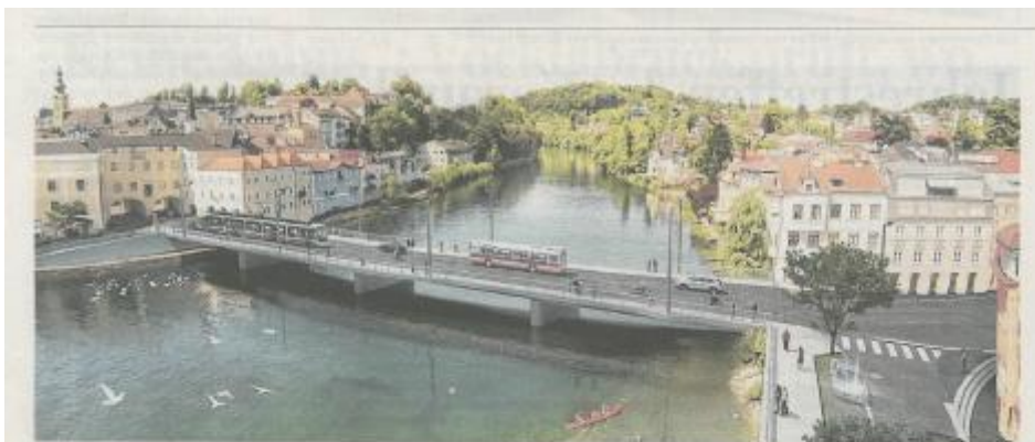
In wenigen Wochen beginnen in Gmunden die Bauarbeiten für die seeseitige Brückenhälfte. Sie wird im nächsten Sommer befahrbar sein. Grafik: StadtGm.
