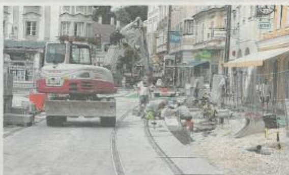
Die Bauarbeiten zwischen Graben und Rathausplatz nähern sich dem Ende zu. Ab 29. August wird der Abschnitt bis zur Traunbrücke in Angriff genommen.
