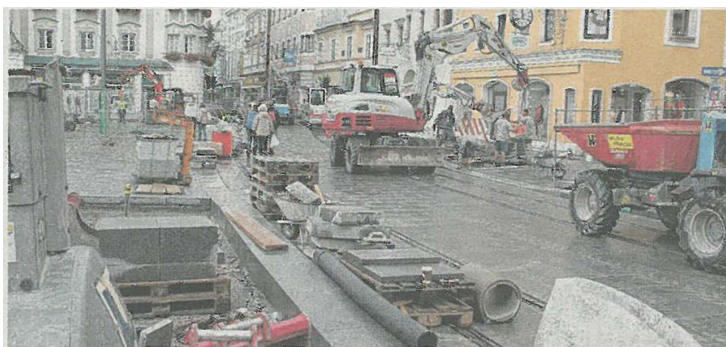
Nachdem vor rund einem Monat die Arbeiten zwischen Graben und Rathausplatz beendet wurden, wird ab 29. August in der Kammerhofgasse weitergebaut.
