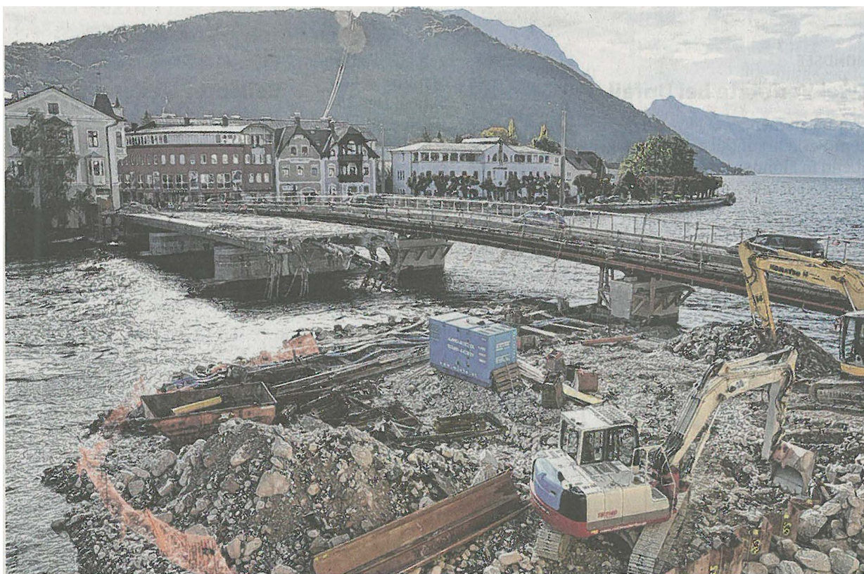
In den kommenden Wochen wird die nördliche Brückenhälfte zur Gänze abgerissen.
