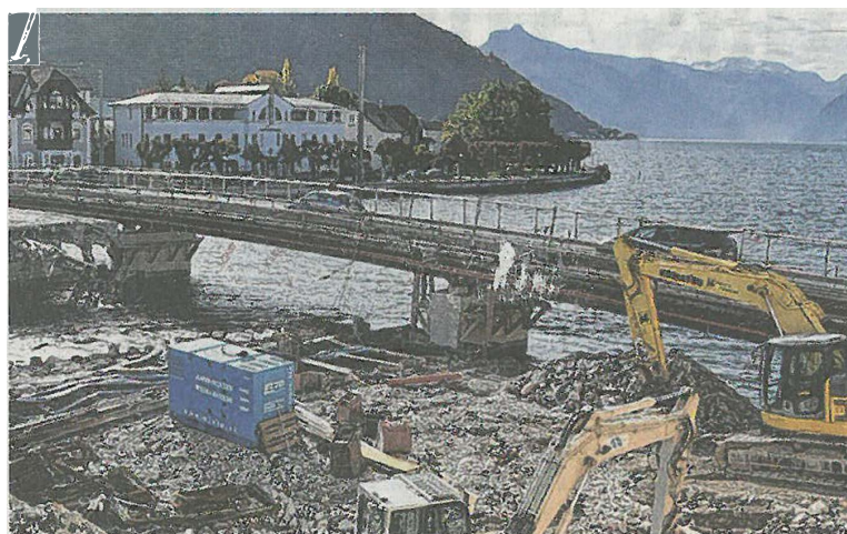
Am Traunsee-Ausfluss entsteht eine neue Brücke.
