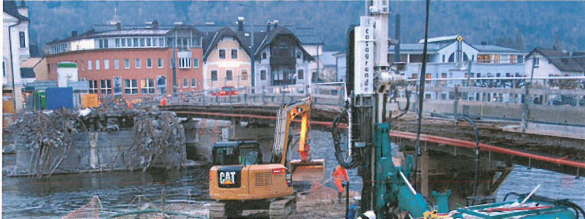
Bauarbeiten an der Traunbrücke. (Foto: Stern & Hafferl)
