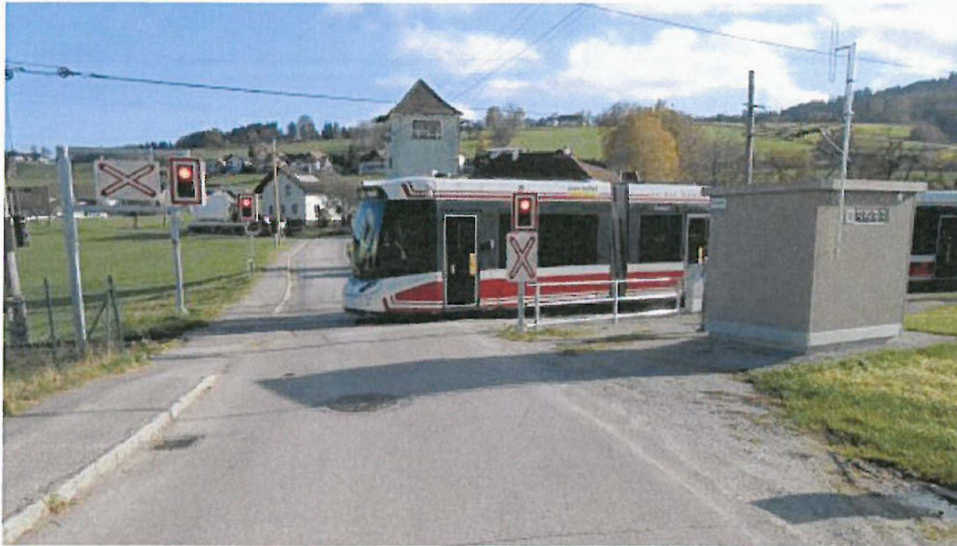
Neue Eisenbahnkreuzung an der Hillingstraße Bild: Stern & Hafferl
