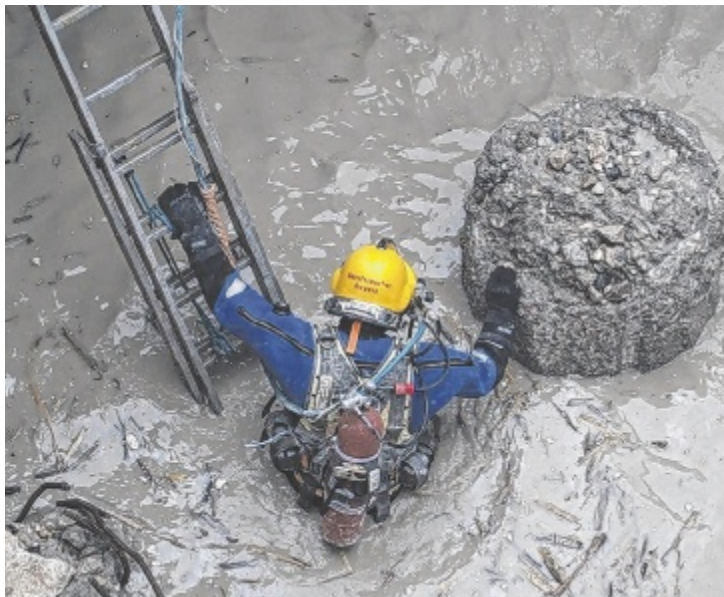
Aus Schaden wird man klug. Mit einer neuen Methode sicherte man die Baugruben für den Bau der neuen Gmundner Traunbrücke.
