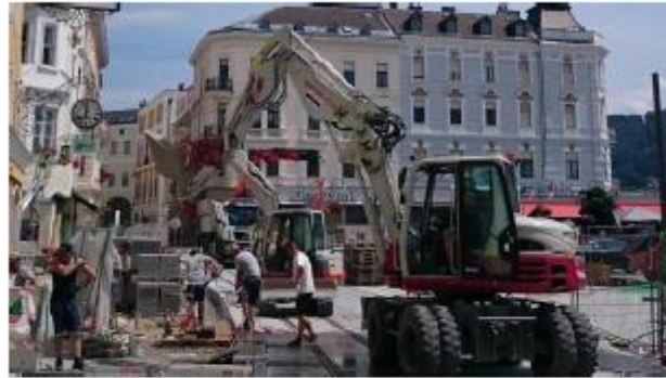
Aktuelle Lage an der Baustelle Bild: (gary)
