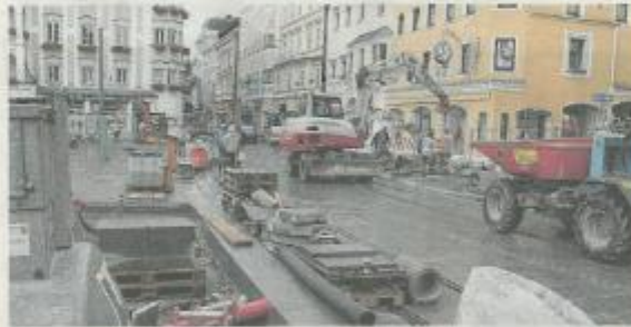
Vorläufiger Endspurt der StadtRegio Tram-Bauarbeiten am Rathausplatz
