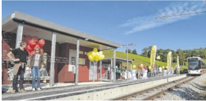
Die neue Haltestelle „Schloss Weyer“ der Traunseebahn in Gmunden befindet sich zwischen Seebahnhof und Lembergweg.
